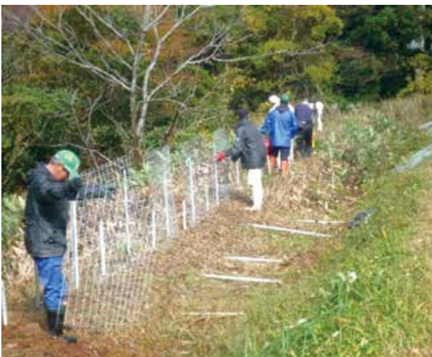
ワイヤーマッシュ柵の設置作業
