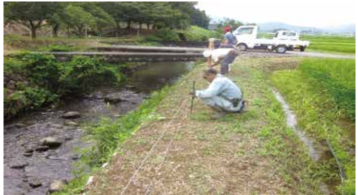
電気柵の設置作業
