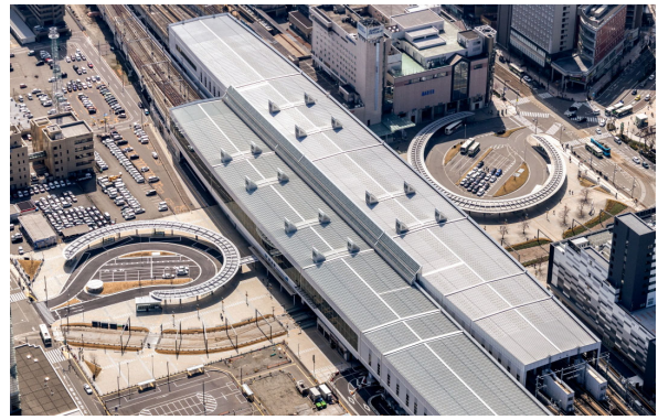
駅北口駅前広場の整備
