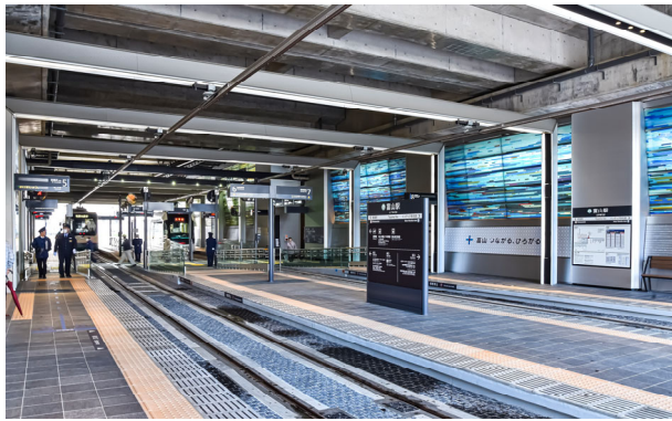
路面電車の南北接続
