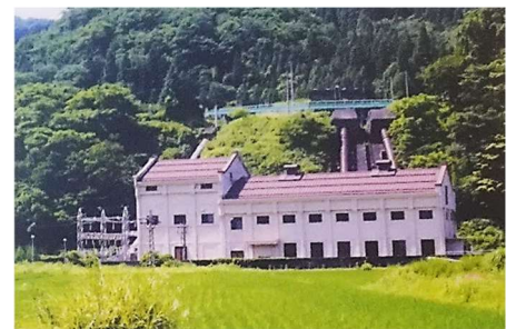
松ノ木発電所
