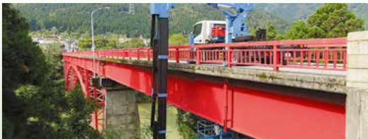
橋りょうの定期点検
