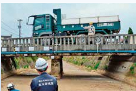
センサーの動作確認(土木研究所との実証実験)
