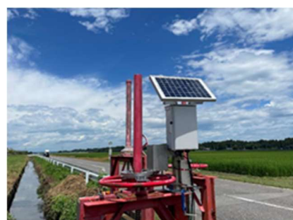
図3-4-4 水門制御装置
