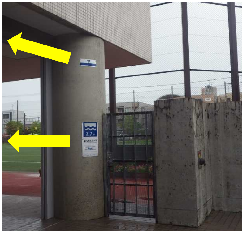
施工例：中央小学校（浸水深 2.7m）
