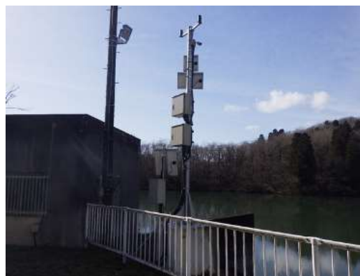
農業用ため池の施設監視（今後の期待される分野）
