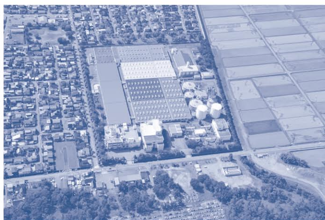
浜黒崎浄化センター
