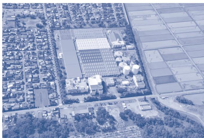
浜黒崎浄化センター
