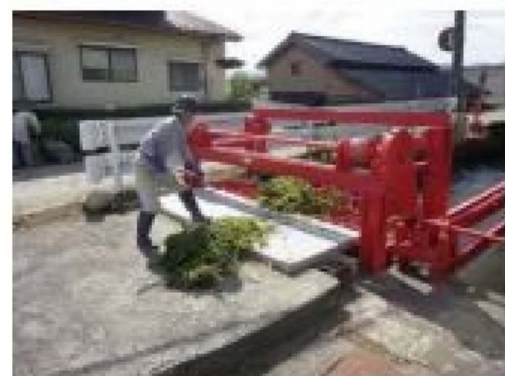
例7 農業用水路内での土砂上げや藻刈りなど、重量物の搬出や流れの中での作業
