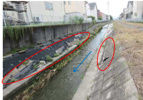
○経堂地区（経堂排水路 水路修繕）
