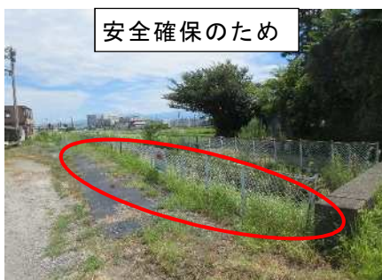
転落防護柵設置
