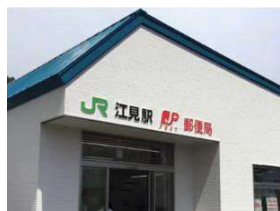
駅舎の 新改築・移設
