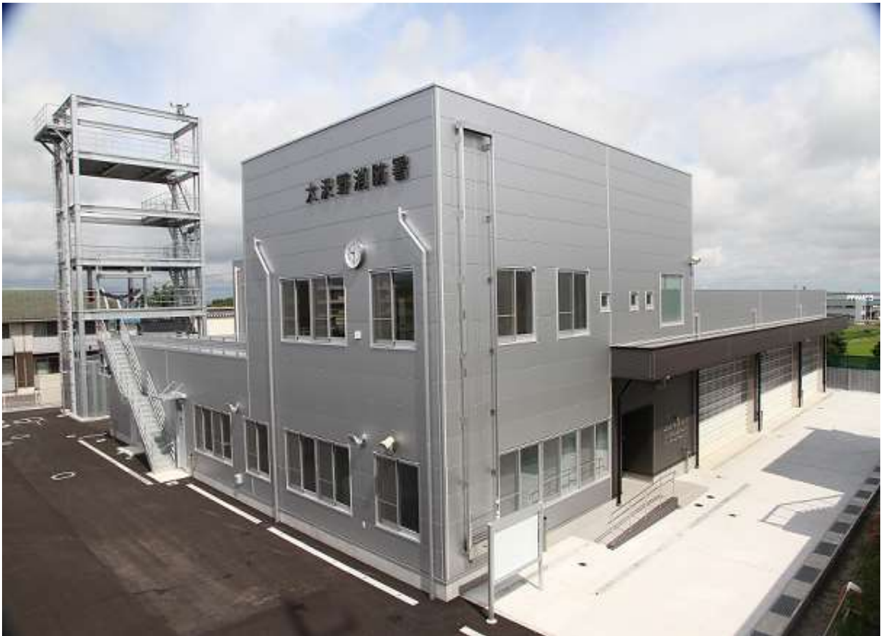
大沢野消防署 新庁舎（令和2年7月運用開始）
