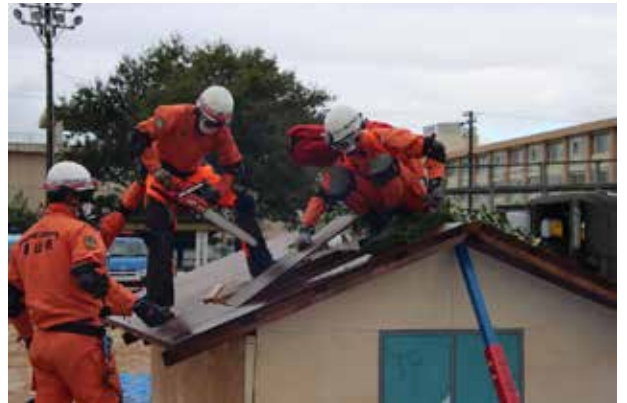
倒壊建物からの救助訓練
