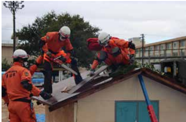
倒壊建物からの救助訓練
