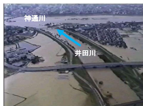
平成16年台風23号の浸水被害 出典：国土交通省資料
