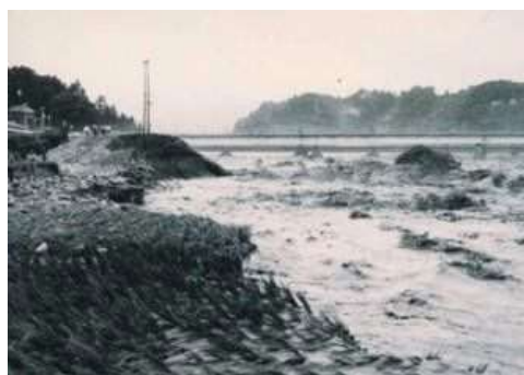
昭和44年8月洪水の堤防決壊状況 出典：国土交通省資料
