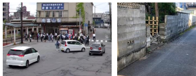
駅前空間及び能登半島地震後の現地写真
