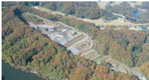
最終処分場 (1985年3月完成) 富山市山本 (池多校区)
