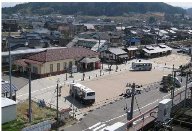
接続状況(越中八尾駅)
