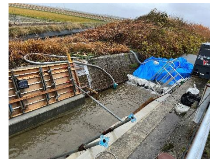
整備工事の仮設状況
