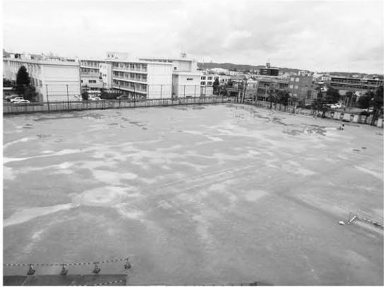
排水性の向上を図る工事が予定されている堀川中学校グラウンド（降雨後）の様子
