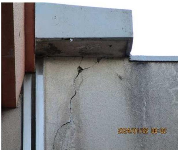
遊戯室前廊下の外壁（外壁破損）
