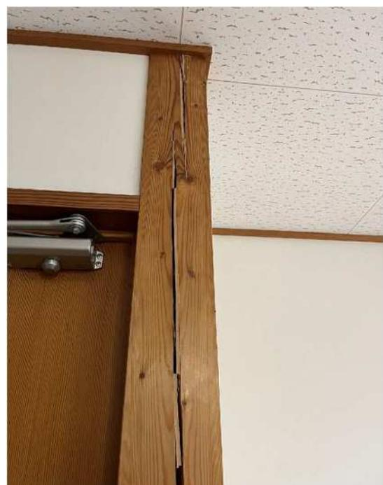
2 階給湯室 (柱亀裂)
