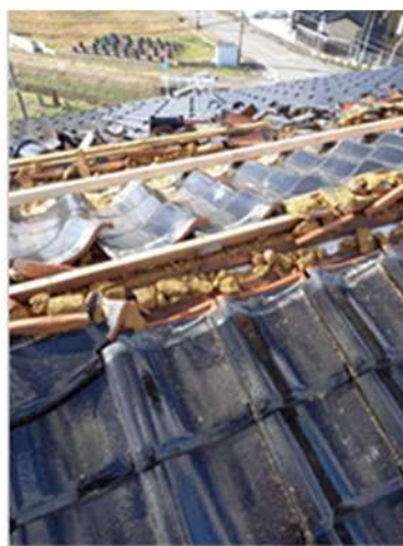
婦中大豆乾燥調製施設の屋根瓦の崩落状況
