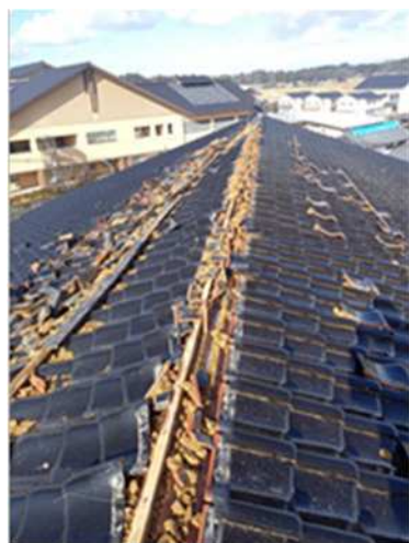
婦中大豆乾燥調製施設の屋根瓦の崩落状況
