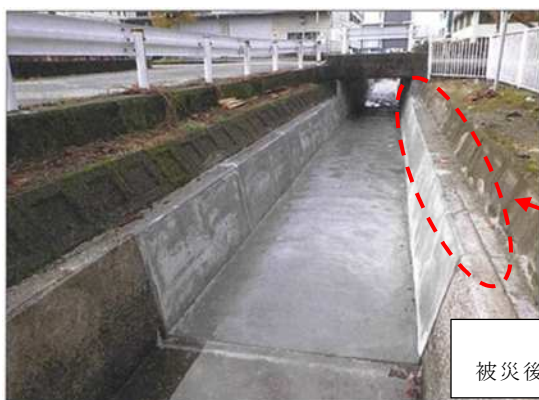
○現場完了時（被災前）
