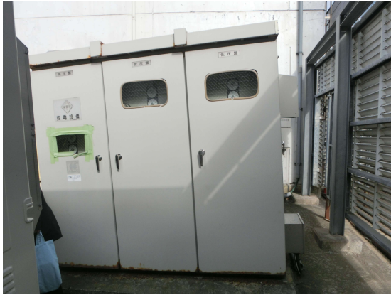
地盤沈下により傾いた設備（貯水槽、キュービクル、エアコン室外機）
