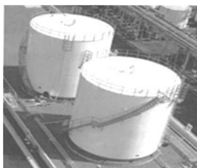
浮き蓋付特定屋外タンク貯蔵所
