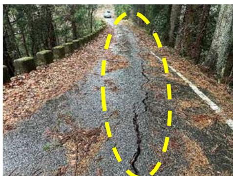
1 箇所目 (舗装亀裂 5 0 m)
