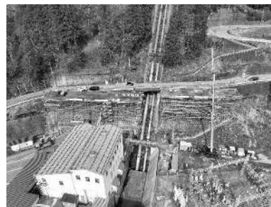
仮橋設置状況
