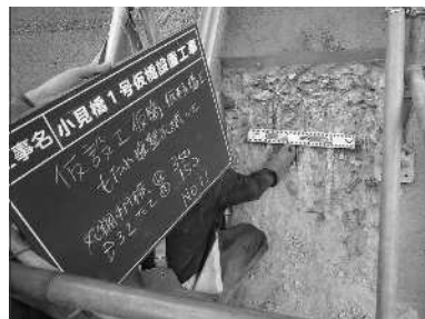
既存擁壁内の鉄筋(φ32mm)
