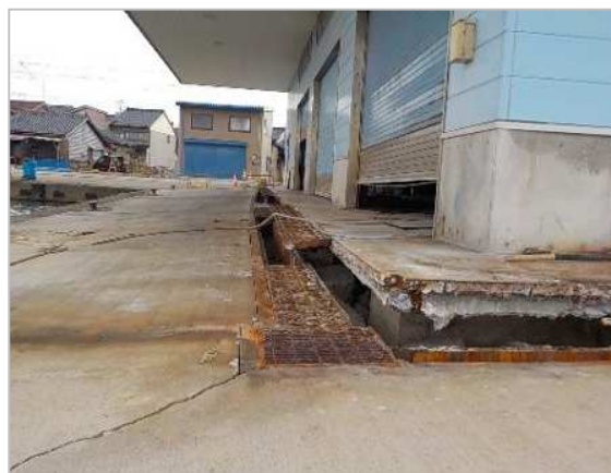
水橋荷さばき所：側溝他
