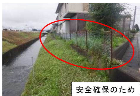
転落防止柵設置
