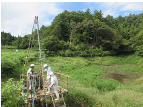
【地震耐性調査実施状況】
