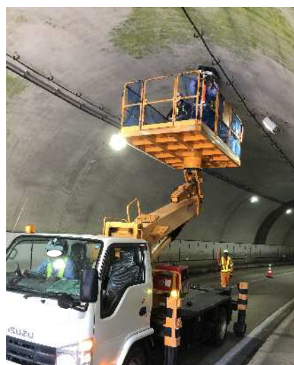
定期点検状況（新婦トンネル） 〔令和5年7月〕
