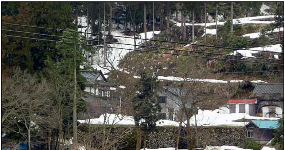
八尾町青根地区（地すべり対策事業）
