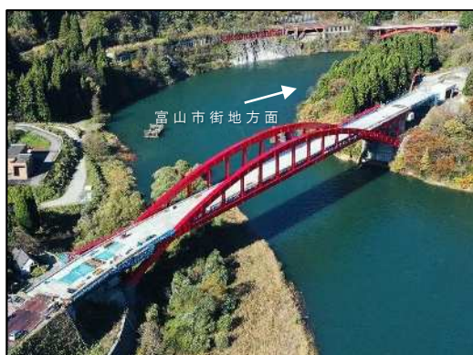
猪谷楡原道路（仮称）猪谷橋施工状況 （令和5年11月 富山市猪谷地内）
