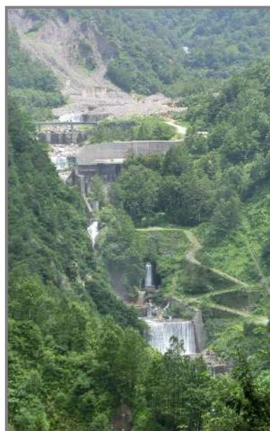
白岩砂防堰堤（重要文化財）
