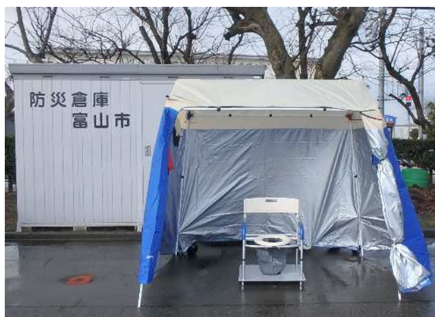
マンホールトイレ (倉垣小学校)
