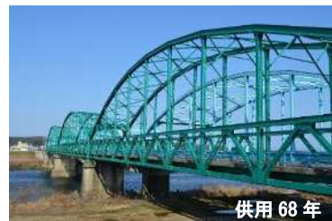
神通大橋（上流側）
