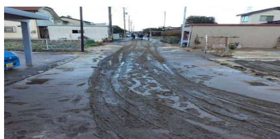
液状化した道路
