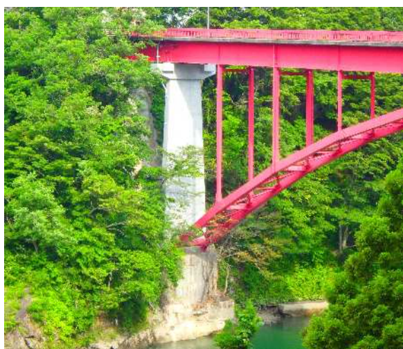
橋梁補修事業（神峡橋） 〔令和5年6月〕
