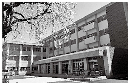
校舎(A棟) 平成30年2月完成
