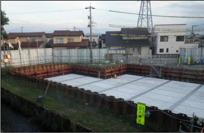
貯留池の整備 (長江東町二丁目地内)
