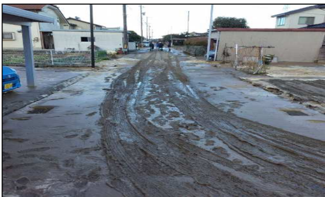
液状化した道路
