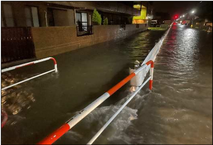
令和5年7月の集中豪雨による浸水被害 (大町地内)
