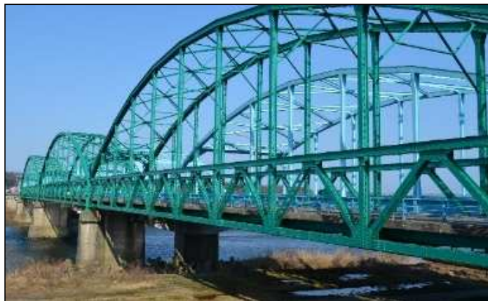
神通大橋(上流側) 市道神通町安養坊線 架設年:昭和31年
