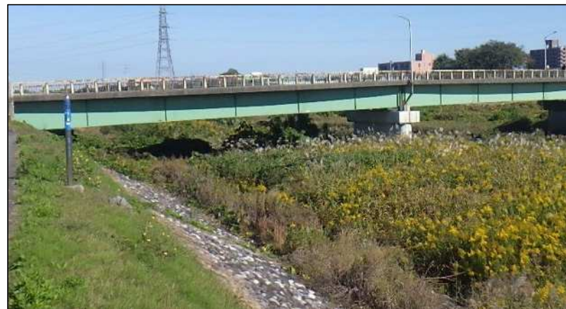
八幡橋(熊野川) 市道萩原黒瀬線 架設年:昭和40年
