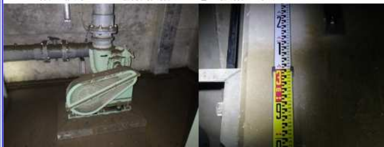
地下階での機器部水没(珠洲市野々江P)
