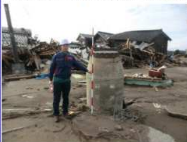
人孔浮上(珠洲市)
