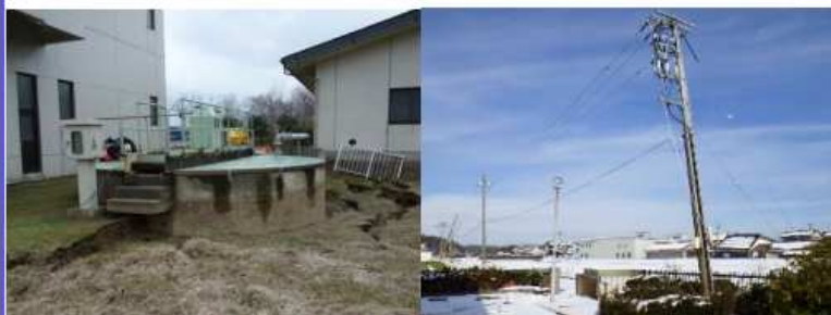
重力濃縮槽浮上り(羽咋市羽咋T)
