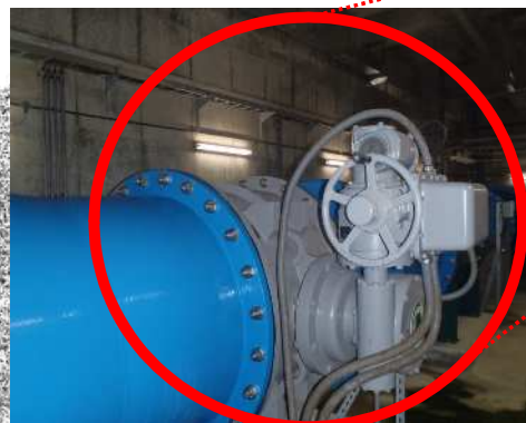
緊急遮断弁(口径1100mm)
