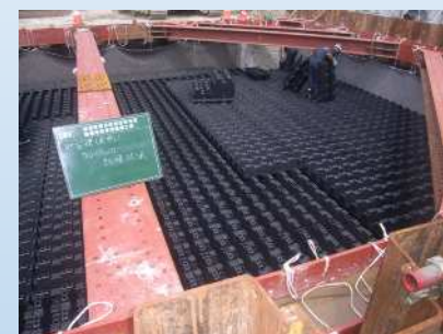
雨水貯留施設の整備
