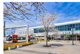
路面電車南北接続
