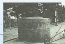
安野屋水源（S24.6月 増設）
