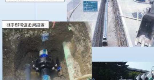
耐震化工事の様子
