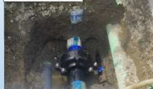
継手部補強金具設置
