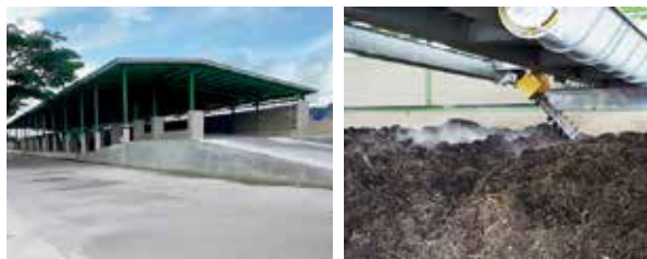
▲コンポストプラント(長さ100m)。1日あたり最大50tの生ごみを処理し、17tのコンポストを製造できます。
