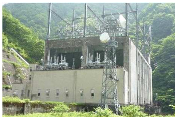
水力発電施設
