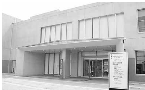
7年度に専用端末を設置することでマイナンバーカードの更新手続き等が可能となる呉羽地区センター
