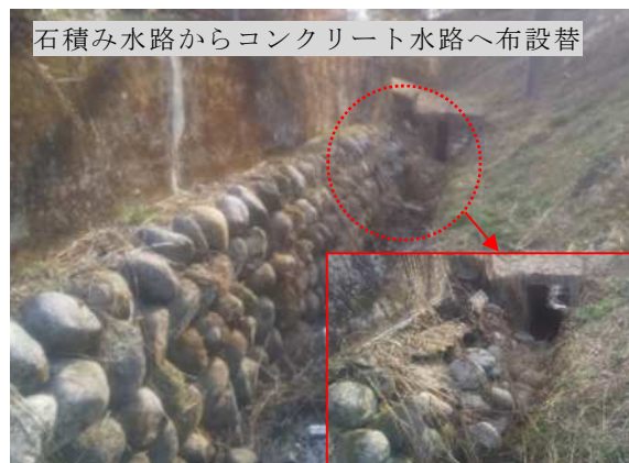
大山地域：水路整備
