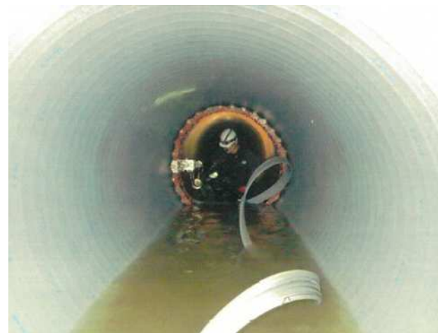
下水道管の更新工事[管更生工法]
