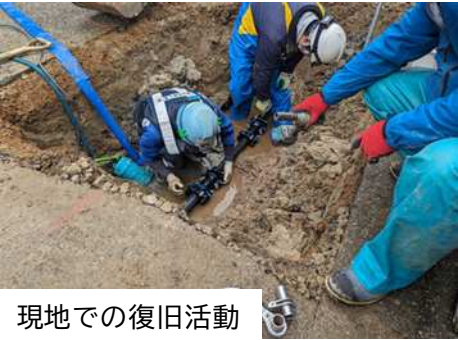
給水車を連結し漏水調査用の水を送水
