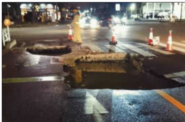
【石川県金沢市】 発生年次：平成27年5月
