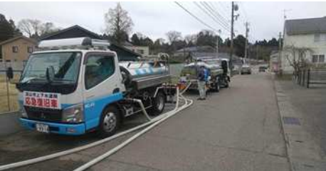
給水車を連結し漏水調査用の水を送水
