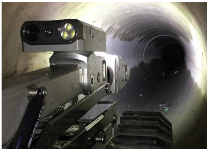
下水道管内を調査する様子
