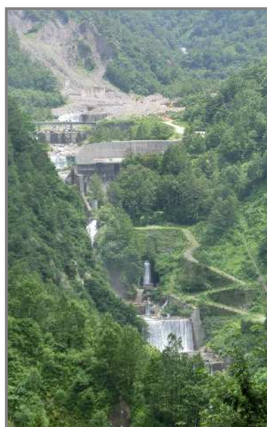
白岩砂防堰堤（重要文化財）
