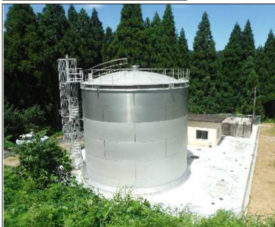
山田低区配水池の耐震化
