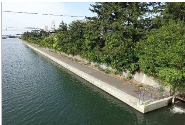
富岩運河（護岸の改修）
