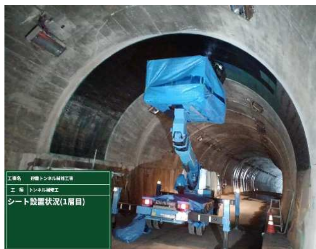
トンネル等保全事業（砂蔵トンネル） 〔令和6年11月〕
