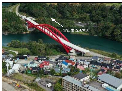
猪谷楡原道路（仮称）猪谷橋施工状況 （令和6年10月 富山市猪谷地内）
