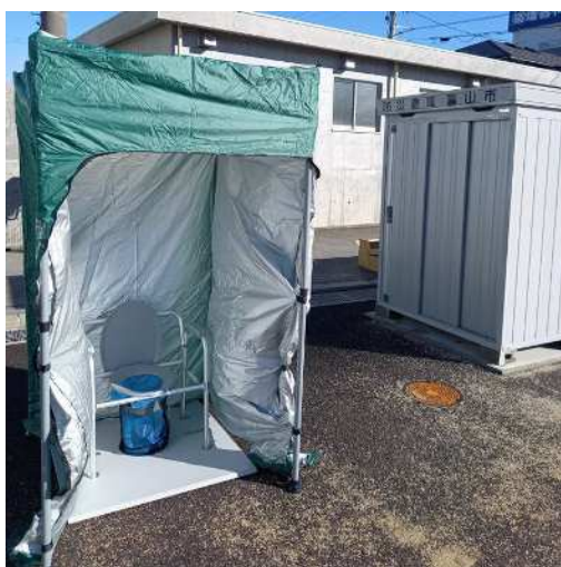
マンホールトイレ (堀川小学校)
