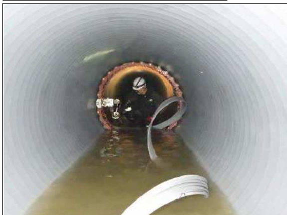
庁星幹線(Φ1400mm)の耐震化
