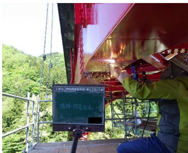
橋梁補修事業（神峡橋） 〔令和6年5月〕
