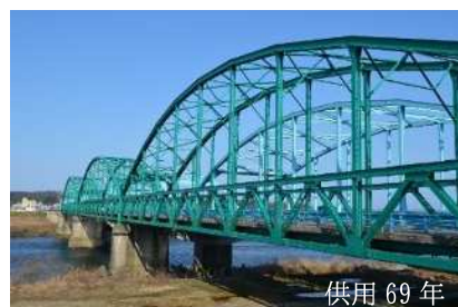
神通大橋（上流側）
