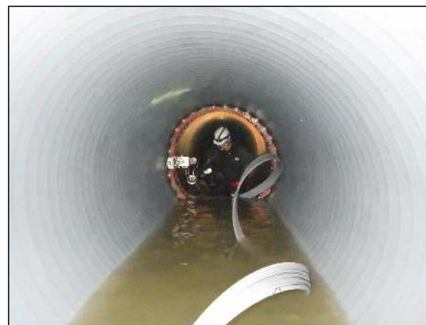
庁星幹線(φ1400mm)の耐震化
