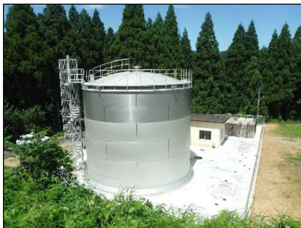
山田低区配水池の耐震化
