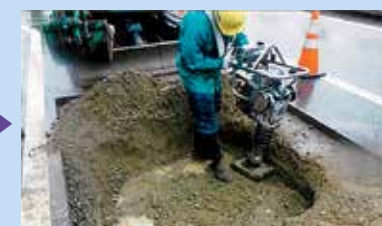
空洞を埋める工事を実施
