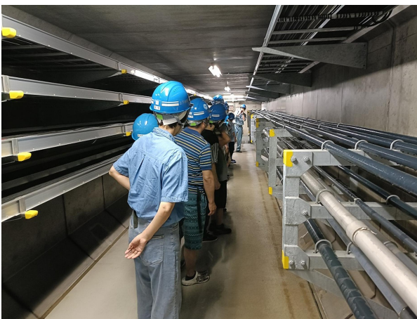
薬品（凝集剤、次亜塩素酸ナトリウム等）を運ぶ配管の見学
