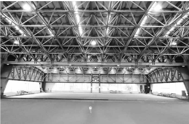
すばーく富山 (富山市屋内ゲートボール場)
