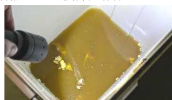
躯体から排出された錆び水 (雨漏りにより躯体内に滞留していたもの)
