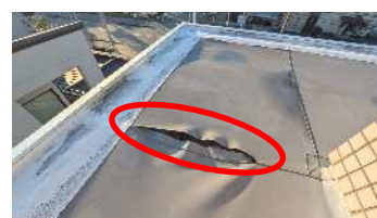
底防水層の状況
