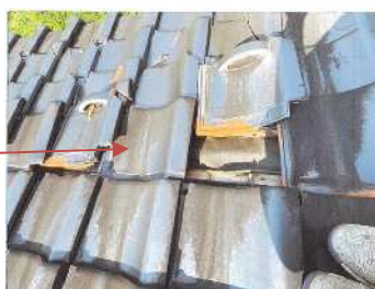
屋根瓦の破損状況
