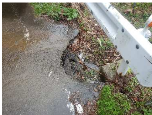
路肩修繕（一覧表：八尾 3）
