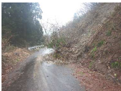
崩土除去（一覧表：八尾 6）
