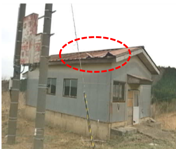
第1 ペアリフト沿い倉庫屋根
