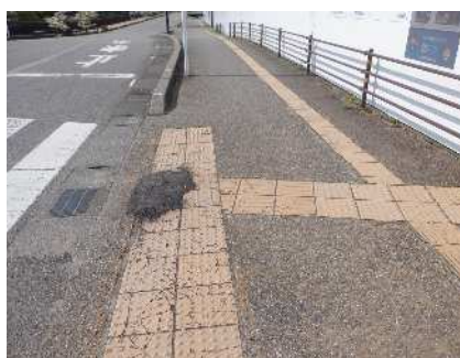
点字ブロック
